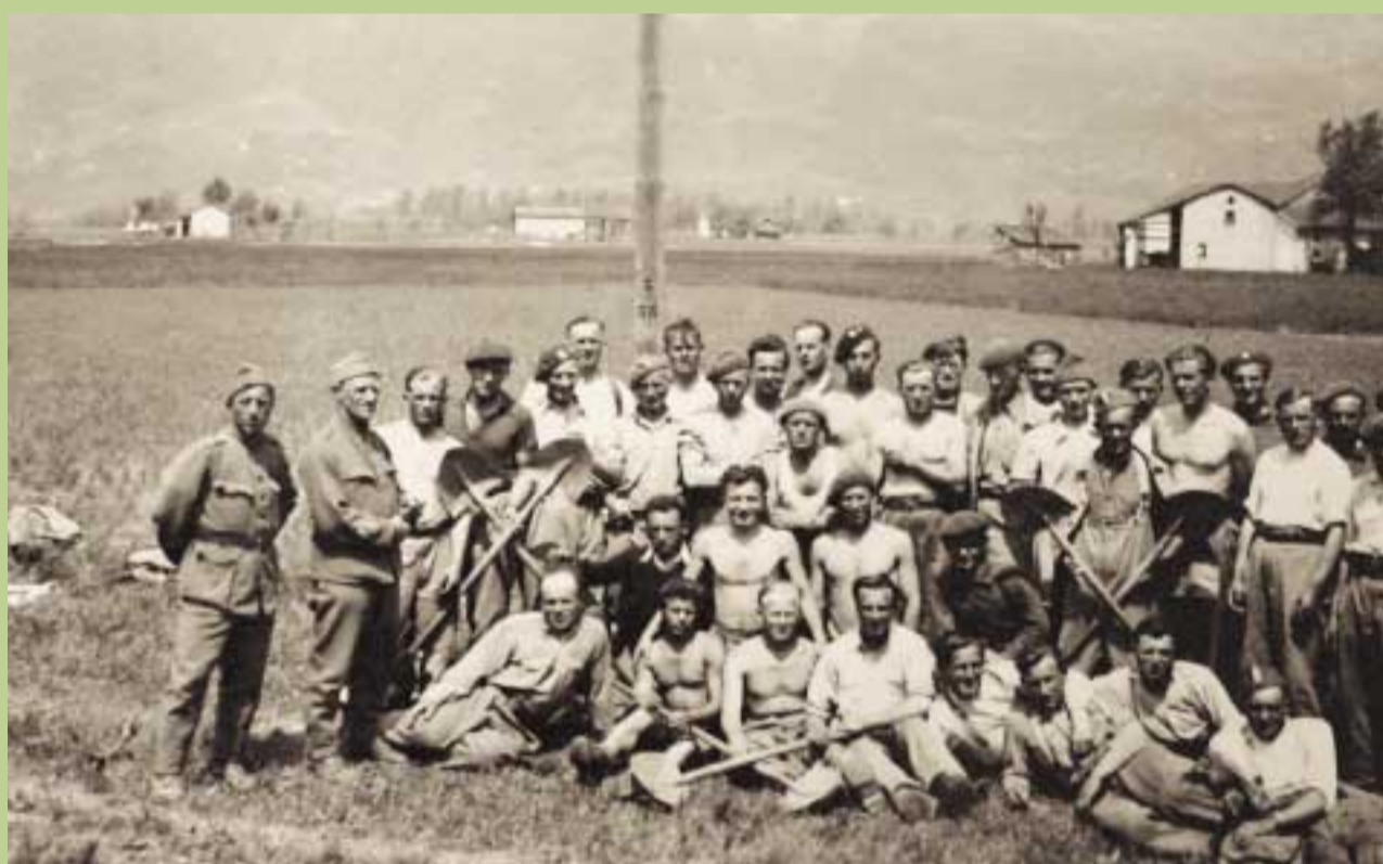
A Gudo, i soldati polacchi eseguirono preziose migliorie in ambito agricolo (dissodamenti, costruzione di canali e di strade, ecc.). Queste opere sono ancora sfruttate al giorno d'oggi dagli abitanti del luogo, la maggioranza dei quali, però, ignora l'identità degli autori.
