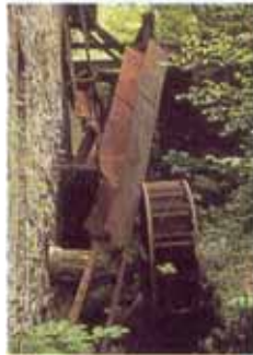
Interno del maglio 1940 ca. Ruota e condotta dell'acqua prima del restauro.
