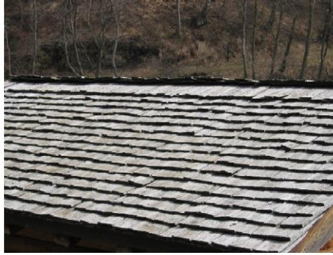
**Figura 44 Esempio di tetto in scandole di castagno lungo il sentiero del castagno (Pron, 2004)**
