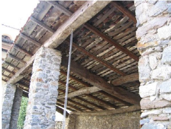
**Figura 42 Esempio di impalcatura di tetto in legno di castagno ad Arosio (Pron, 2004)**
